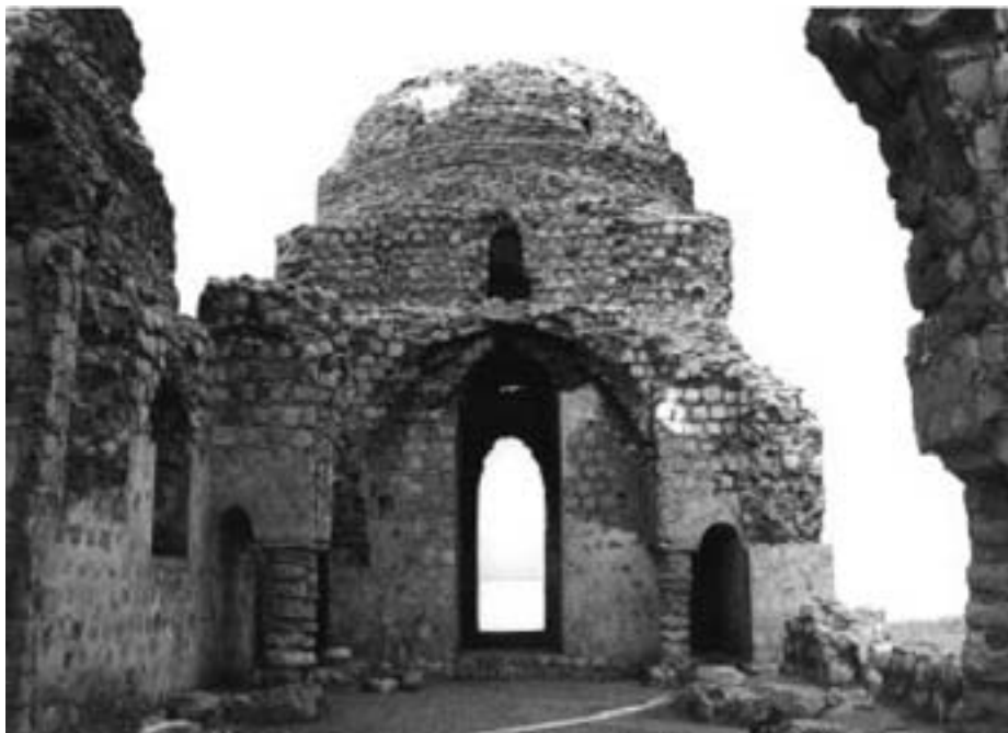
FIG. 8. Roofing structure at the palace of Sarvestan. Photo: © Deutsches Archäologisches Institut, Eurasien-Abteilung.
