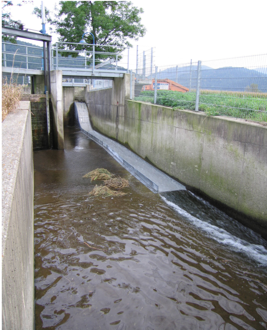
Fischabstieg am WKW Elz; Quelle: Archiv Wasserkraft Volk AG
